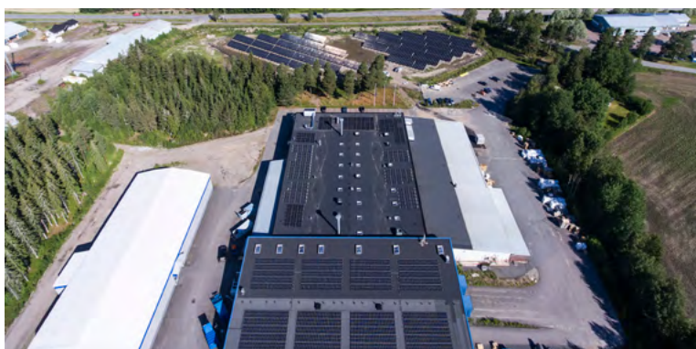
Solcellepark og -installation på taget hos Coreplast Laitila Oy.
