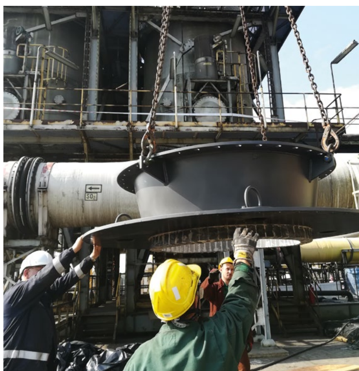
Korrosionsbeskyttende Accoshield® belægning – del til den kemiske industri.
